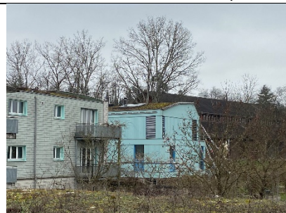
Ansicht Dach Zone 3 von Nordost
