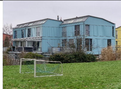
Ansicht von Süden Zone 3 (PV-Module an Balkon)
